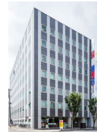
EME郡山ビル
