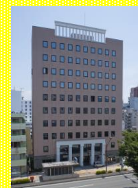
長野セントラルビル
