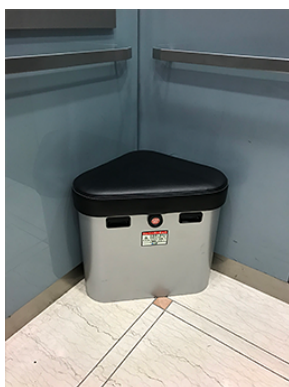
NTビルEV内非常用備品
