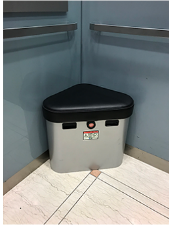
NTビルEV内非常用備品
